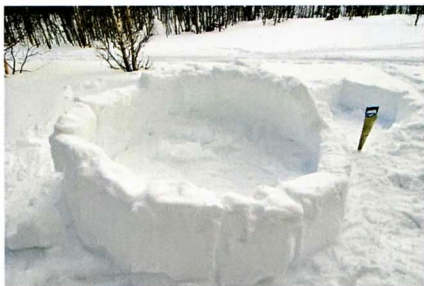
Блоки из снега устанавливают по кругу, ряд за рядом.
