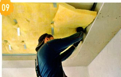
09 Маты укладывал без зазоров — впритык к профилям.
