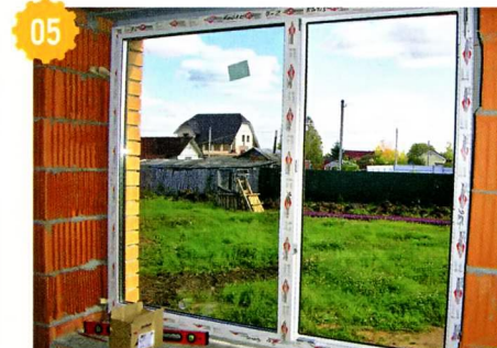
05 Рама закреплена на турбовинты.
