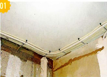
01 Перед монтажом каркаса на потолке была сделана электропроводка.
