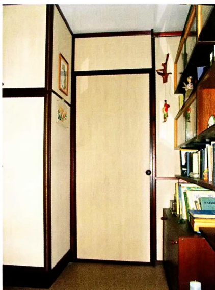
Сдвижная дверь. Верхний механизм подвески закрыт экраном.
