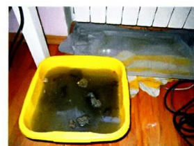
Результат промывки внешне чистого радиатора.
