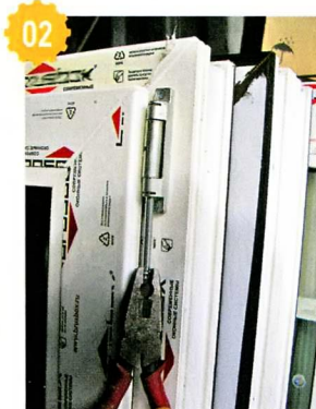
02 Перед установкой окон снимаем створку...
