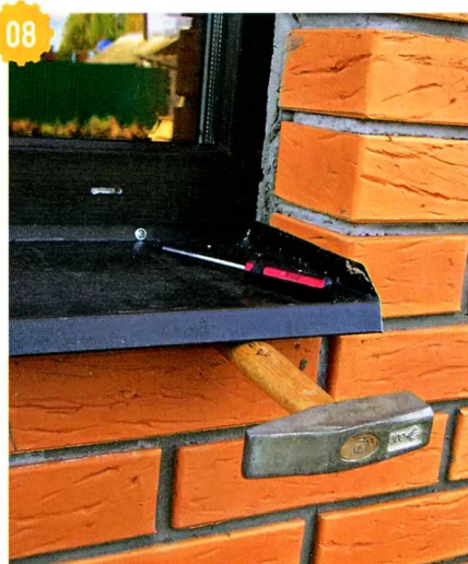
08 При монтаже отлива его задний загиб должен попасть в специальный паз в раме.
