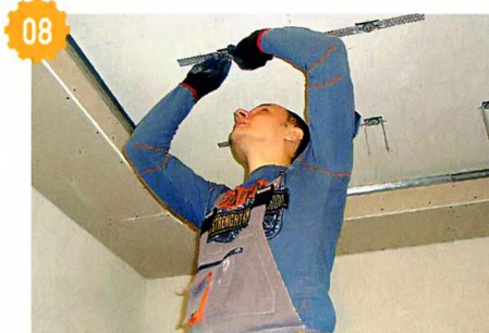
08 Установил подвесы в центральной части потолка.
