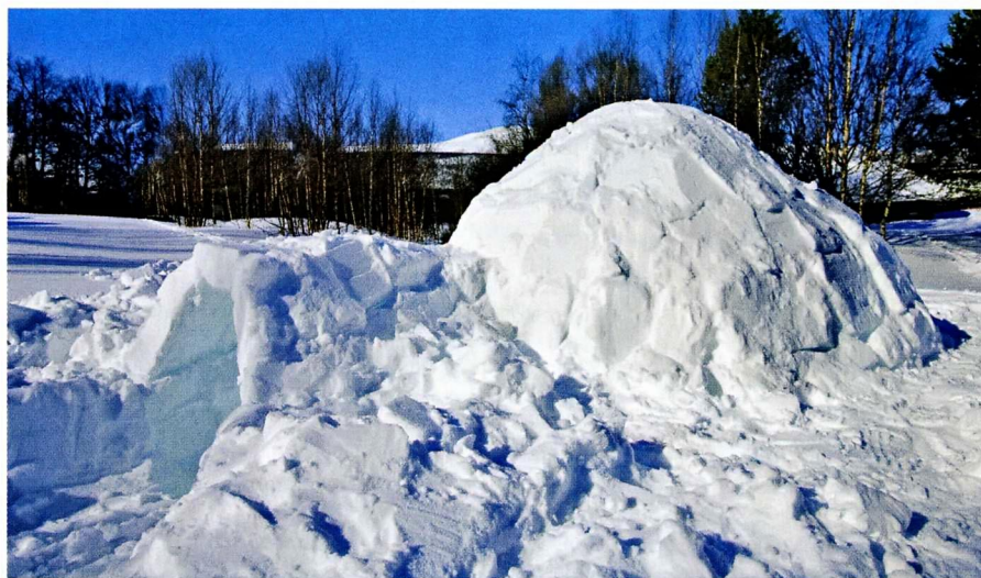
Вход в иглу устраивают через небольшой низкий коридор, перекрытый сводом из снежных блоков.
