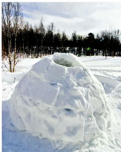
Оставшееся сверху небольшое отверстие перекрывают специально вырезанным блоком...
