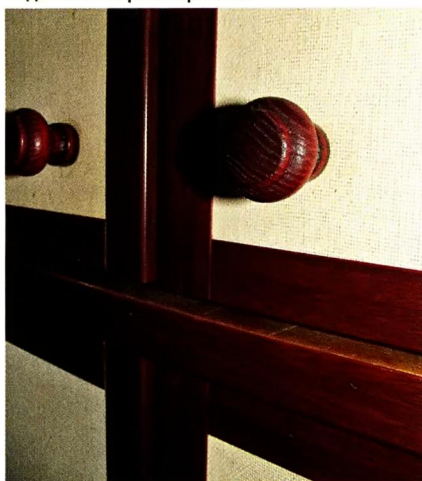
Фрагмент отделки двери. В открытом положении дверь выступает внутрь проёма на 80 мм, поэтому ручки установил обычные, не утопленные.
