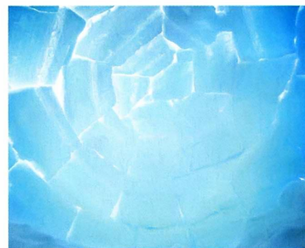
Внутри иглу днём светло благодаря свету, поступающему через полупрозрачные снежные блоки.
