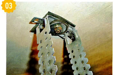
03 Самодельное демпферное крепление на основе прямого подвеса.
