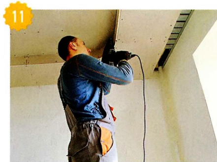
11 При монтаже гипсокартона возле закруглённых участков конструкции требуется особая осторожность.
