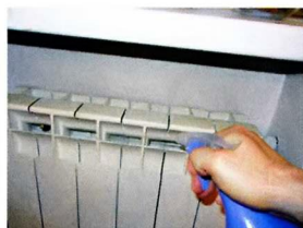
Профилактическая ежедневная очистка радиатора отопления.
