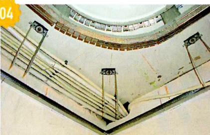
04 Смонтировал каркас на периферической части потолочной плиты.
