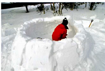
Со второго ряда блоки начинают заваливать внутрь для образования купола.
