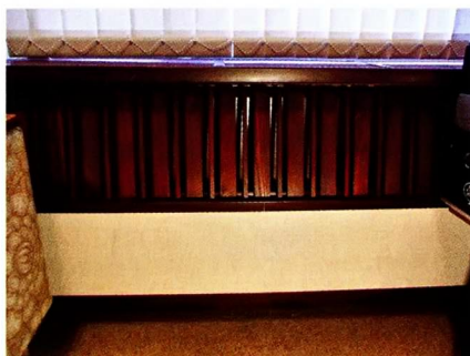
Экран батареи отопления. Решётка сделана из отходов реек, нижняя часть — HDF-панель, оклеенная тканью, на деревянном каркасе.
