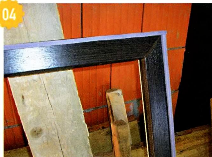
04 По краю наружной стороны рамы перед установкой наклеиваем ПСУЛ.
