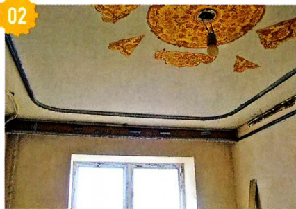
02 Профили к потолочной плите и стенам крепил через демпферную ленту.
