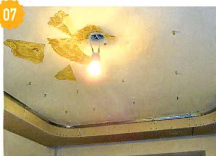
07 Периферическую часть потолочной конструкции обшил гипсокартоном.
