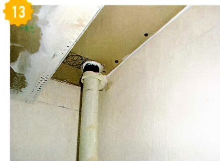
13 Стояк центрального отопления тоже может передавать вибрации, поэтому его нужно развязать с каркасом и гипсокартонной обшивкой.
