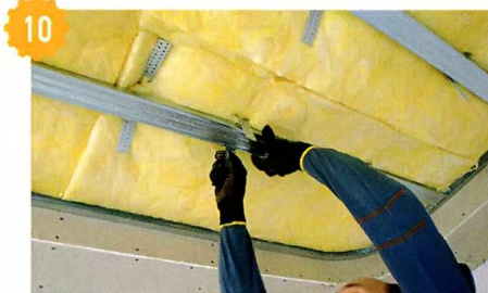
10 Подвесы в центральной части устанавливал с меньшим шагом, чтобы обеспечить запас прочности конструкции.
