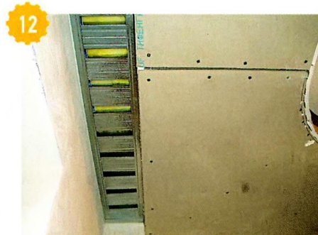
12 Под карниз для штор сделал небольшое углубление. Чтобы было к чему потом его прикрутить, устанавливал профили с небольшим шагом.
