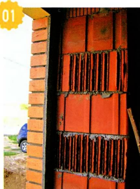
01 Выровненная четверть гарантирует плотное прилегание рамы.
