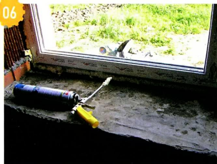
06 Устанавливаем створку и стеклопакет глухой части, после чего щели между рамой и стенками проёма тщательно запениваем.
