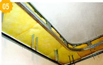
05 Заполнил каркас минеральной ватой.
