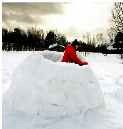
В верхних рядах устанавливают блоки меньших размеров.
