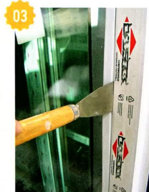
03 ...и стеклопакет с глухой части окна.
